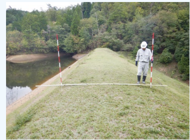
ため池の点検
