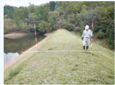
ため池の点検
