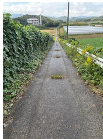
パイプラインが埋設された農道
