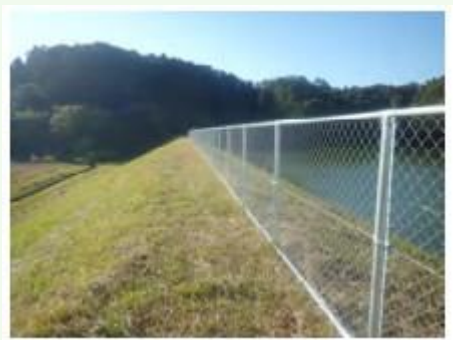
フェンス設置事例
