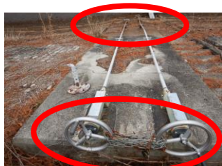
④ ハンドルやゲートの作動状況
