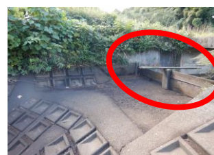
⑦ 洪水吐を角落として堰上げ
