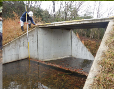
現地での施設点検
