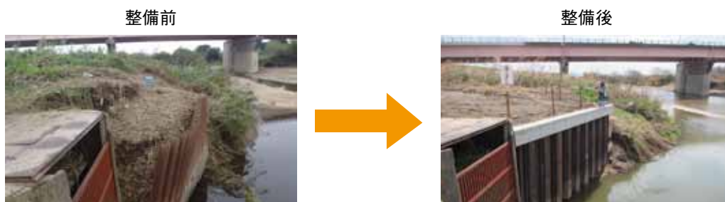
土地改良施設維持管理適正化事業で整備された施設（揚水機場の鋼矢板護岸）
