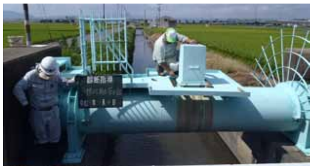
パイプライン（空気弁）の診断
