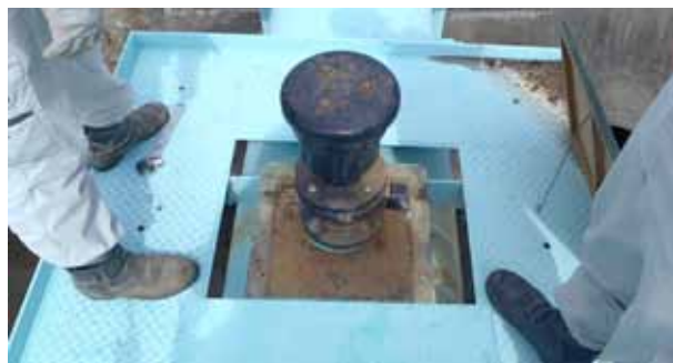
パイプライン（空気弁）の診断
