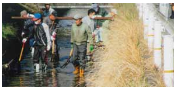
浚渫・草刈風景
