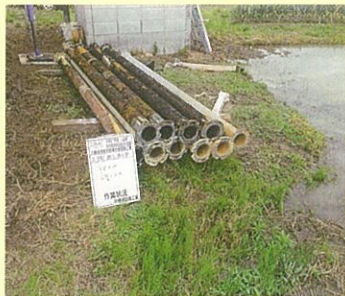
老朽化した揚水管
