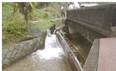
小水力発電現地調査
