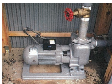
揚水ポンプの更新
