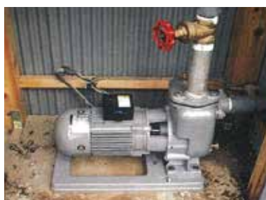
揚水ポンプの更新
