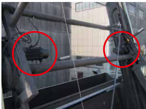
排水機場の除塵機(減速機)整備 (防災減災)
