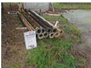
井戸ポンプの揚水管更新
