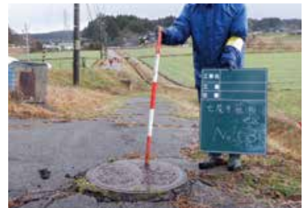
農業集落排水施設の調査作業
