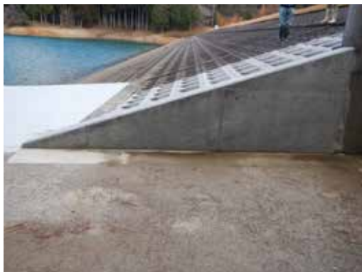
防災重点ため池の整備(防災減災)
