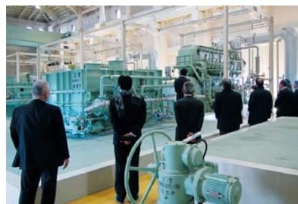
第2回理事会 現地視察(巨椋池排水機場)
