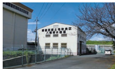
八幡排水機場（昭和38年築造）
