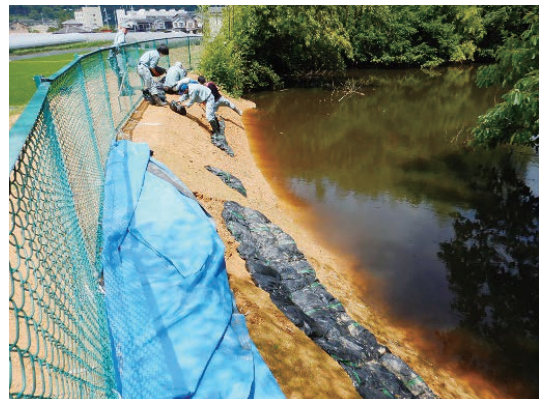
現地指導状況（土壌補修作業）
