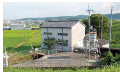
田辺排水機場（昭和34年築造）
