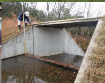
現地での施設点検
