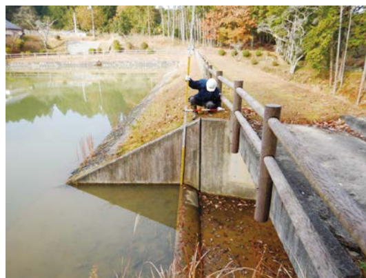
ため池点検状況
