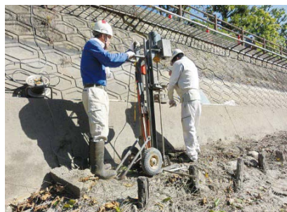
ため池の護岸改修にかかる地盤調査
