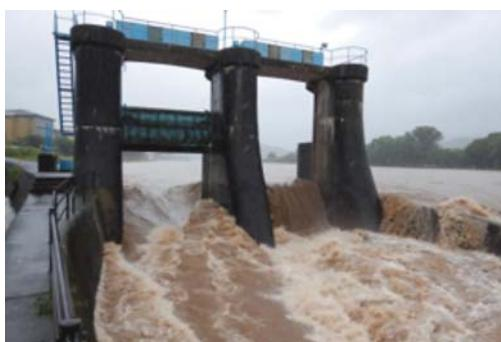
洪水時土砂吐ゲートの稼働不良(ゲートが上昇しない【写真右】)
