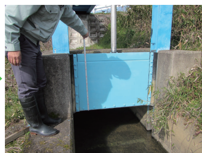
土地改良施設維持管理適正化事業で整備された施設(ゲート塗装)
