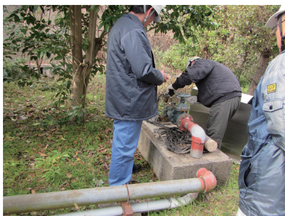
井戸地上部の診断
