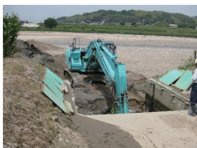
取水口の土砂撤去作業
