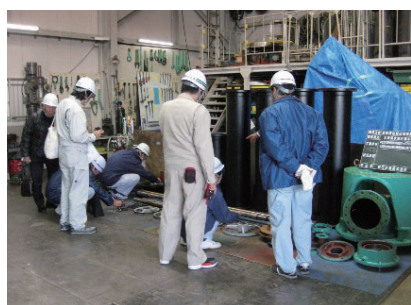
揚水ポンプのオーバーホール立会
