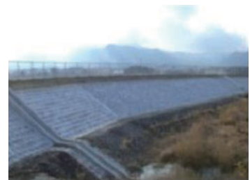
防災工事（堤体の補強）
