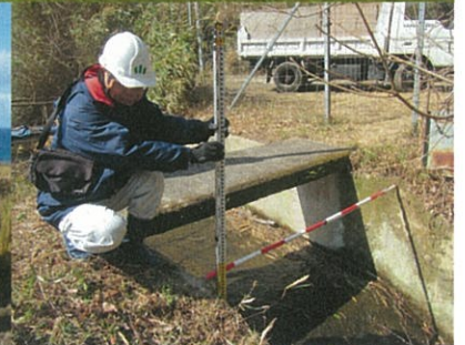
現地での施設点検
