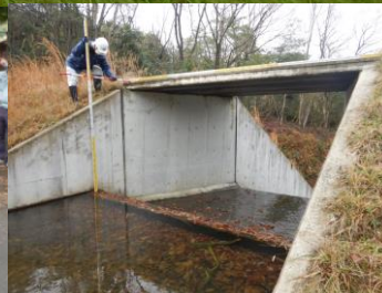
現地での施設点検
